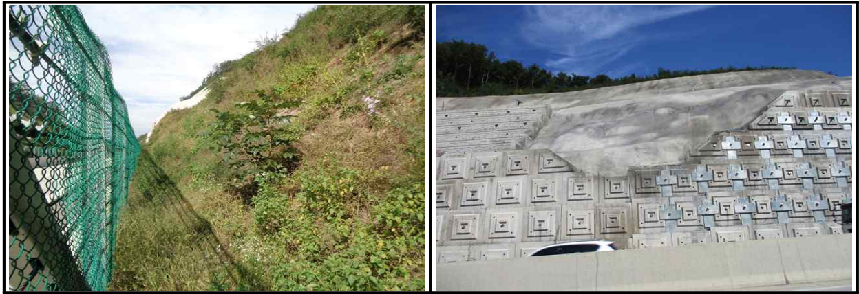
【그림 37.3.4】 보호/보강시설 전경
