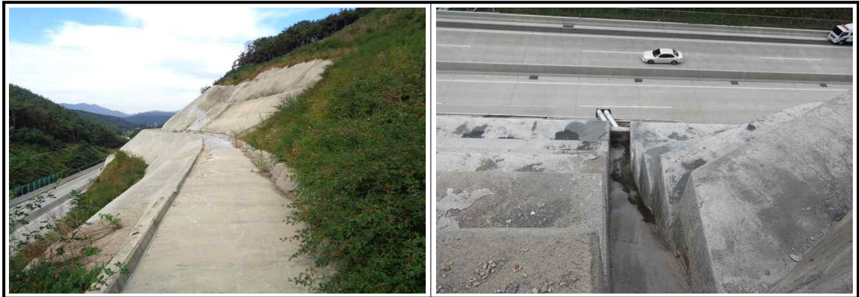
【그림 37.3.3】 배수시설 전경
